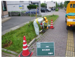
道路パトロール補修状況
