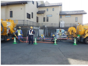
側溝清掃状況
