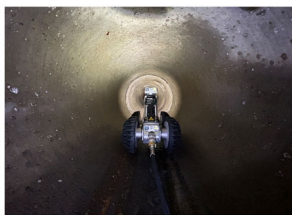
管内内状況 (カメラロボット自走)
