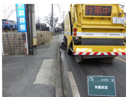
路面清掃状況
