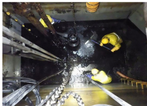
ポンプ井清掃状況
