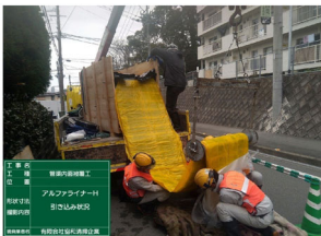
更生材引込み状況
