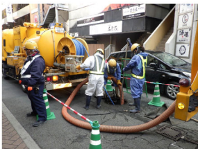
下水道管内清掃状況
