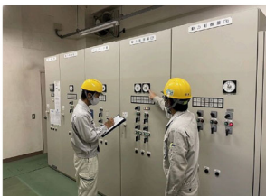
ポンプ場点検状況
